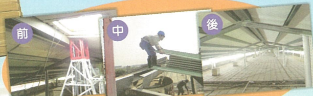
A棟大樓屋頂防水整修工程
