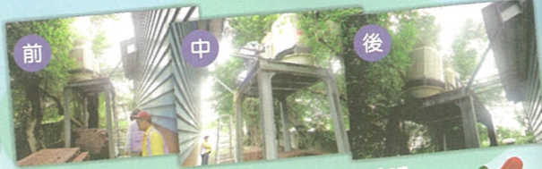
多元學習教室空調水塔清洗
