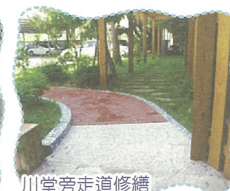
川堂旁走道修繕
