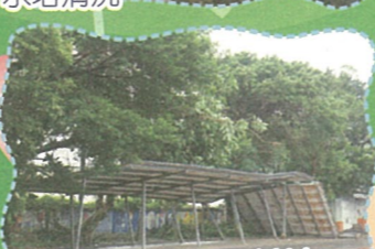
蘇力颱風復建工程(前)
