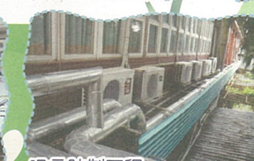
噪音防制工程
