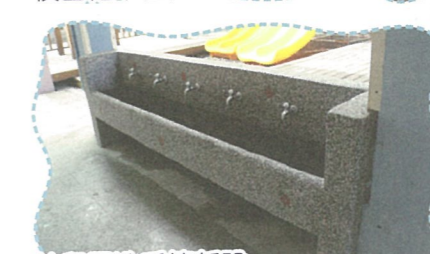
幼兒園洗手檯新設
