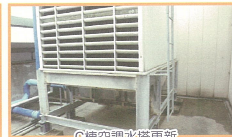
C棟空調水塔更新
