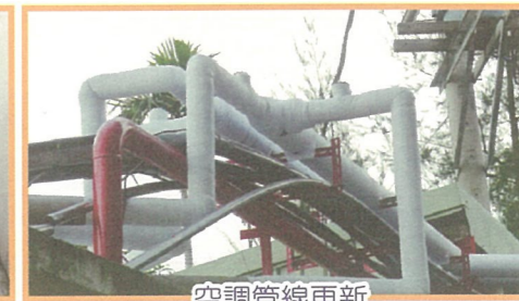
空調管線更新
