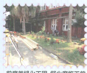
前庭美綠化工程-舒心廊施工前
