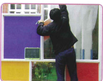
陽光屋玻璃安全防護-施工中
