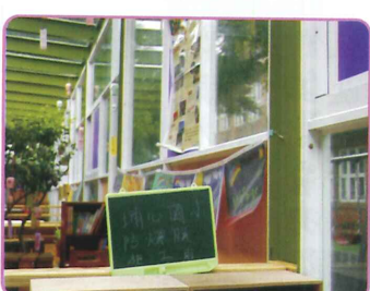
陽光屋玻璃安全防護-施工前
