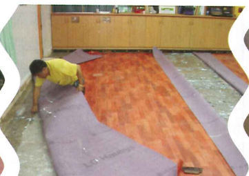
特教班暨幼稚園地板修繕工程
