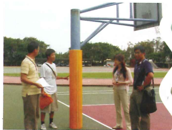
校園雜項修繕設施更新工程
